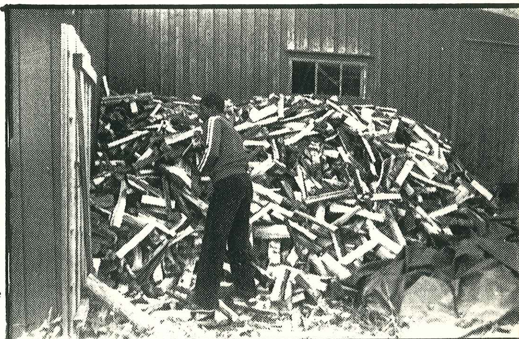
Komi på dagsverks-arbete för Sv. Togoföreningen, d.v.s. för CRASF.
