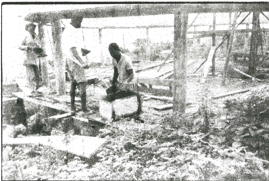
Les travaux de la construction du réfectoire au C.R.A.S.E. de Kuma-Dunyo.
